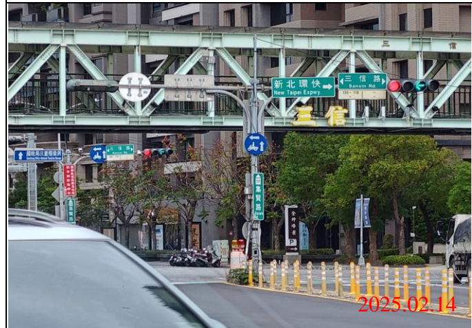
巡查日期地點：114.02.14/ Y23車站 照片說明：牌面設置狀況
