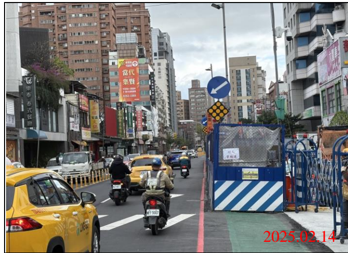
巡查日期地點：114.02.14/ Y21車站 照片說明：牌面設置狀況
