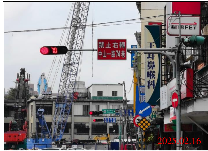
巡查日期地點：114.02.16/ Y21車站 照片說明：牌面設置狀況
