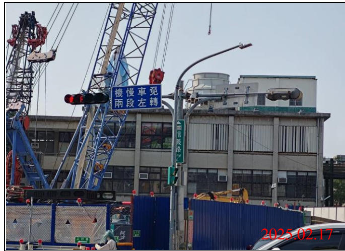
巡查日期地點：114.02.17/ Y21車站 照片說明：牌面設置狀況
