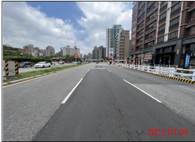
巡查日期地點：112.07.09/ Y23車站 照片說明：路面狀況
