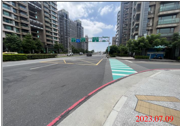
巡查日期地點：112.07.09/ Y23車站 照片說明：路面狀況
