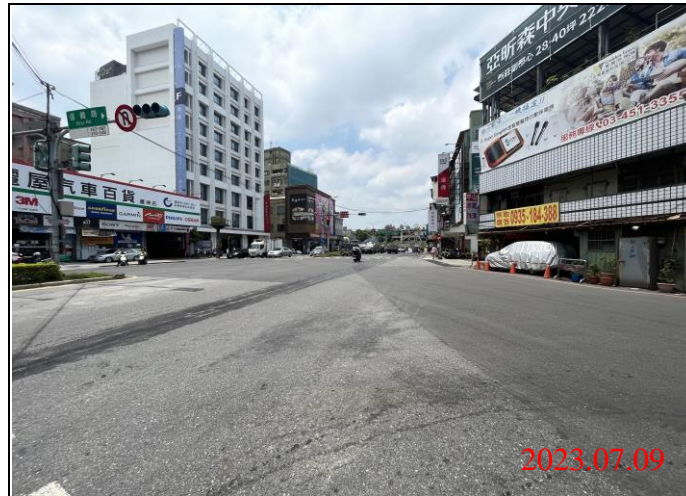
巡查日期地點：112.07.09/ Y21車站 照片說明：路面狀況
