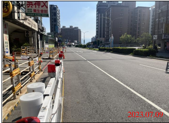
巡查日期地點：112.07.09/ Y22車站 照片說明：路面狀況
