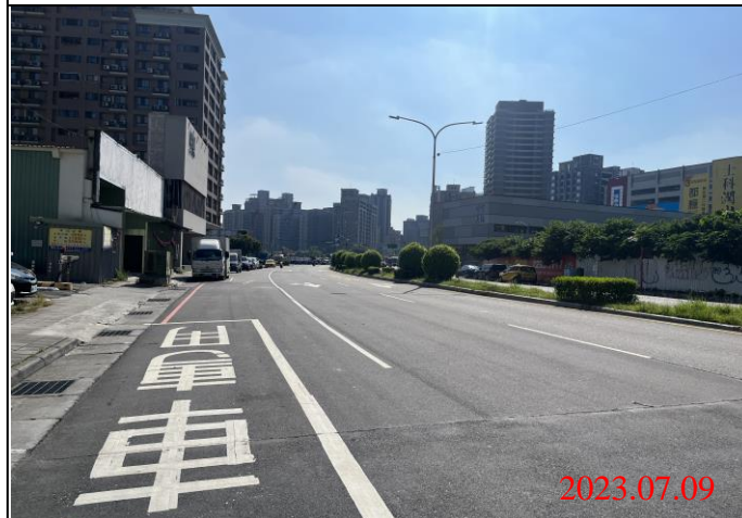
巡查日期地點：112.07.09/ Y22車站 照片說明：路面狀況
