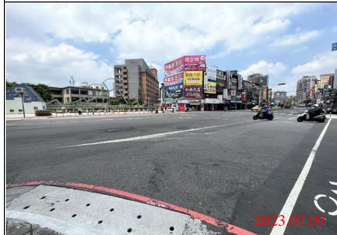
巡查日期地點：112.07.09/ Y21車站 照片說明：路面狀況
