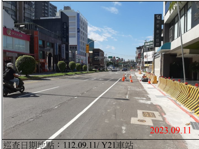
巡查日期地點：112.09.11/ Y21車站 照片說明：路面狀況
