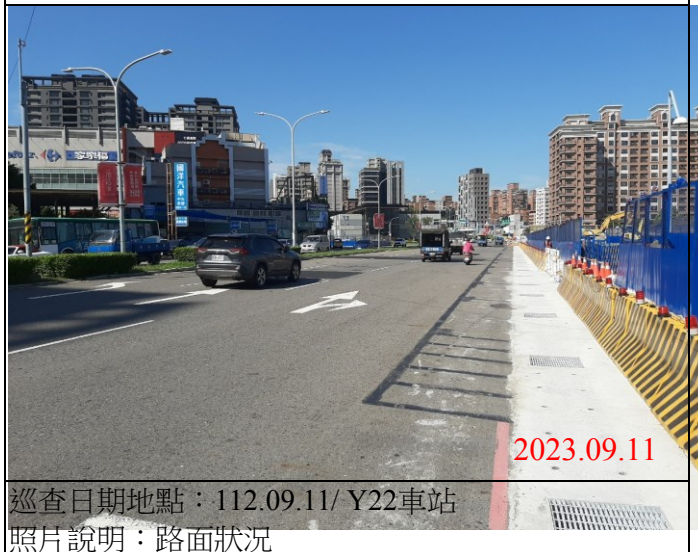
巡查日期地點：112.09.11/ Y22車站 照片說明：路面狀況
