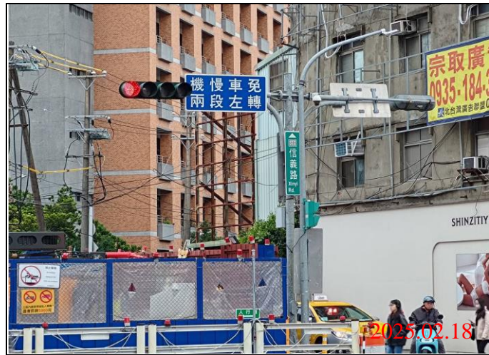
巡查日期地點：114.02.18/ Y21車站 照片說明：牌面設置狀況
