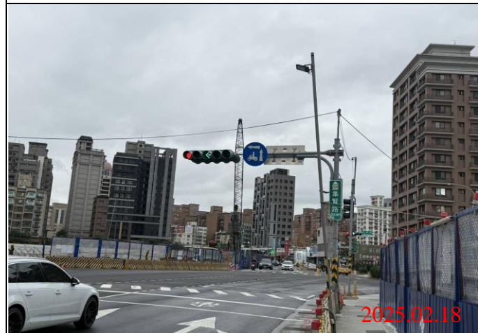
巡查日期地點：114.02.18/ Y22車站 照片說明：牌面設置狀況
