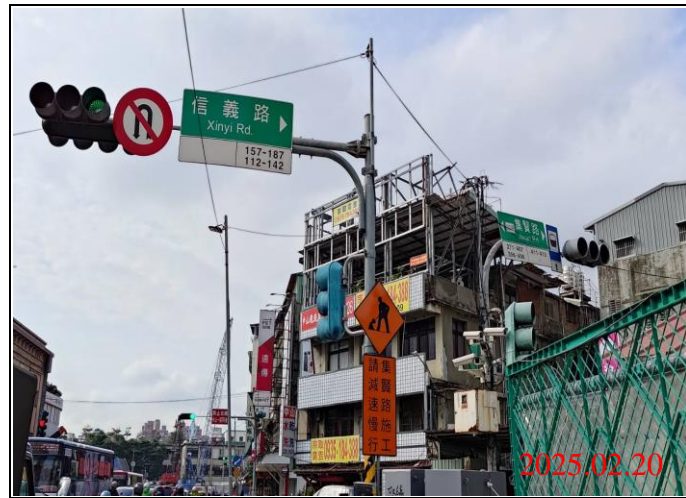
巡查日期地點：114.02.20/ Y21車站 照片說明：牌面設置狀況
