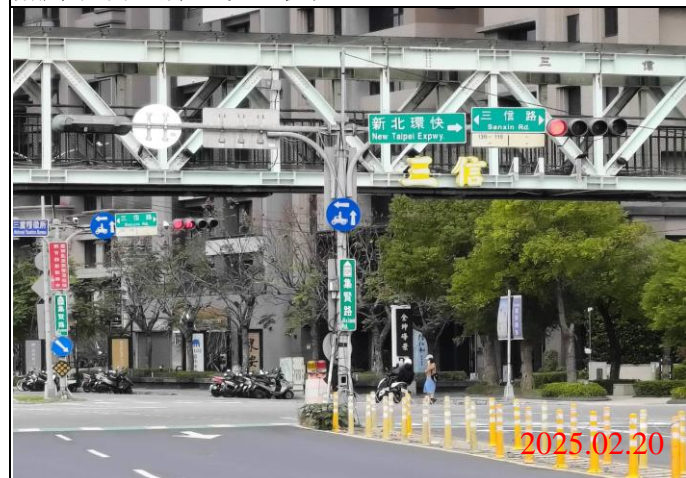
巡查日期地點：114.02.20/ Y23車站 照片說明：牌面設置狀況
