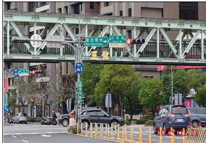
巡查日期地點：114.02.21/ Y23車站 照片說明：牌面設置狀況
