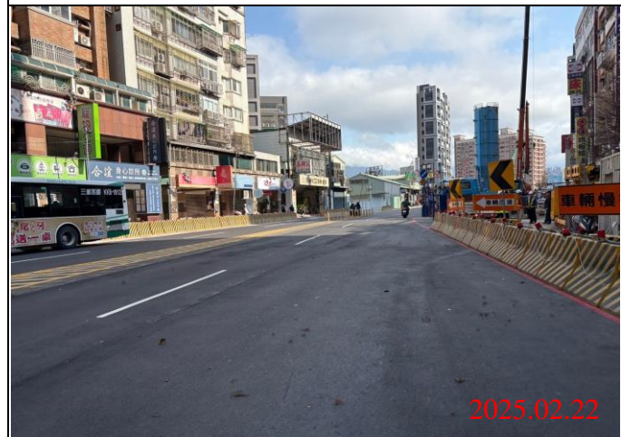
巡查日期地點：114.02.22/ Y22車站 照片說明：牌面設置狀況
