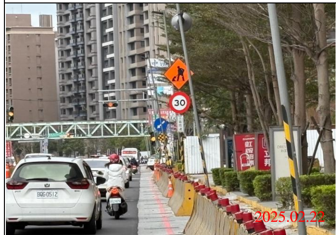
巡查日期地點：114.02.22/ Y23車站 照片說明：牌面設置狀況
