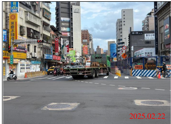
巡查日期地點：114.02.22/ Y21車站 照片說明：牌面設置狀況
