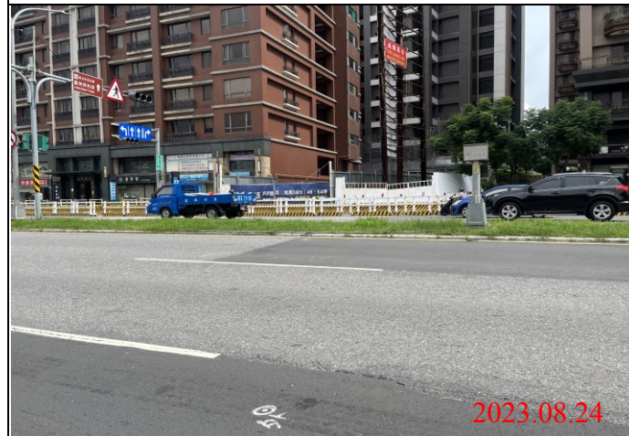
巡查日期地點：112.08.24/ Y23車站 照片說明：路面龜裂狀況
