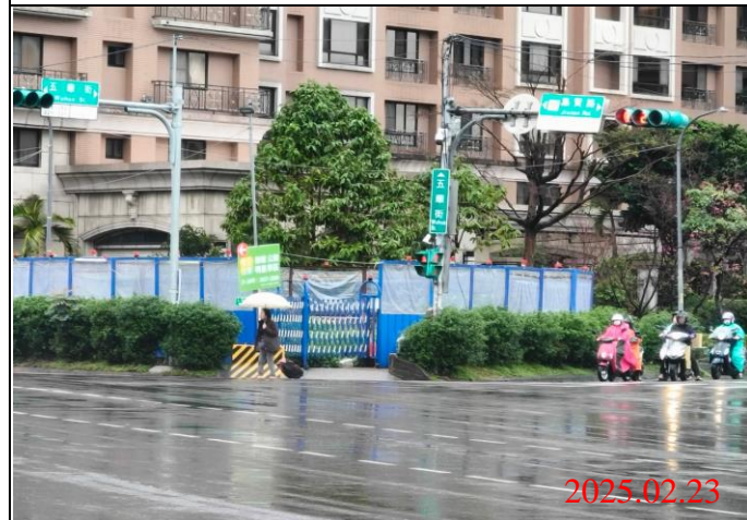
巡查日期地點：114.02.23/ Y22車站 照片說明：牌面設置狀況
