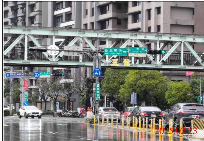
巡查日期地點：114.02.23/ Y23車站 照片說明：牌面設置狀況
