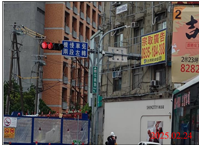
巡查日期地點：114.02.24/ Y21車站
