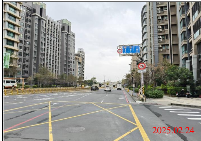
巡查日期地點：114.02.24/ Y23車站
