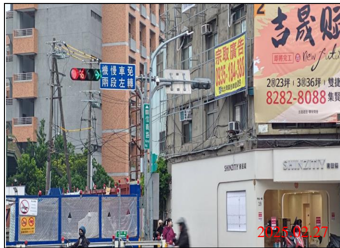
巡查日期地點：114.02.27/ Y21車站
