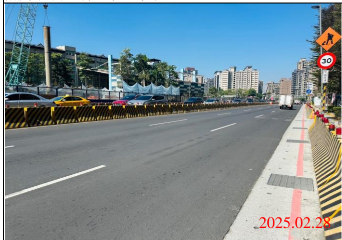
巡查日期地點：114.02.28/ Y23車站 照片說明：牌面設置狀況
