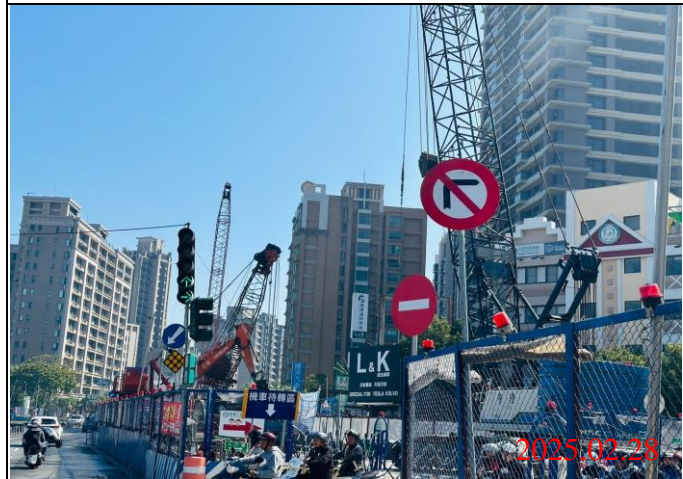
巡查日期地點：114.02.28/ Y22車站 照片說明：牌面設置狀況
