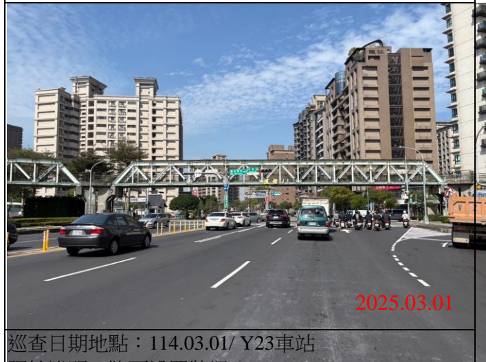
巡查日期地點：114.03.01/ Y22車站 照片說明：牌面設置狀況
