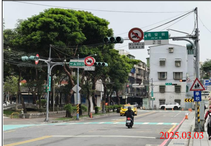
巡查日期地點：114.03.03/ Y23車站 照片說明：牌面設置狀況
