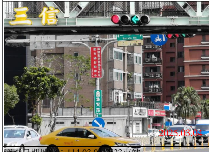
巡查日期地點：114.03.04/ Y23車站 照片說明：牌面設置狀況
