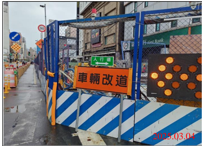
巡查日期地點：114.03.04/ Y21車站 照片說明：牌面設置狀況
