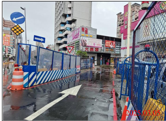
巡查日期地點：114.03.05/ Y21車站 照片說明：牌面設置狀況
