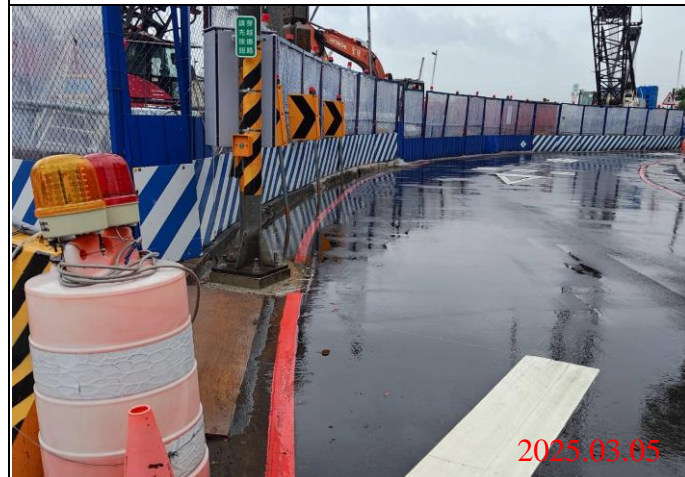
巡查日期地點：114.03.05/ Y22車站 照片說明：牌面設置狀況
