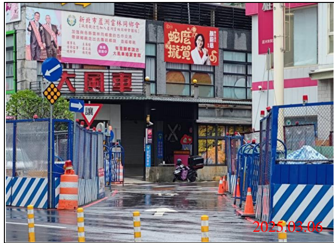
巡查日期地點：114.03.06/ Y21車站 照片說明：牌面設置狀況
