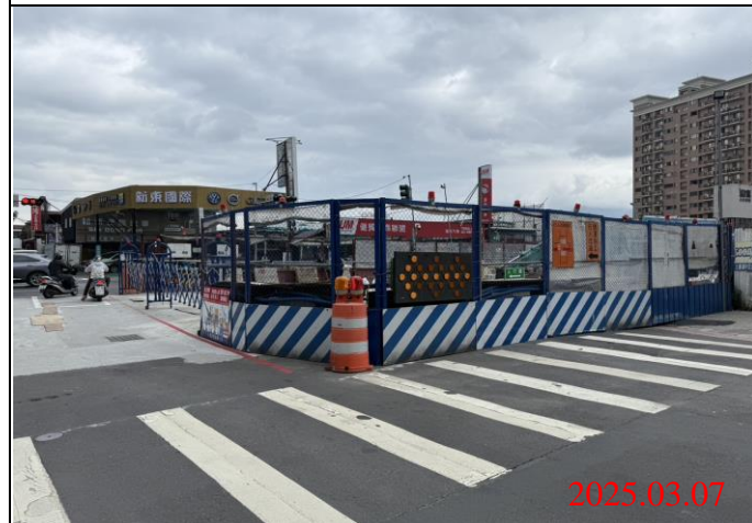
巡查日期地點：114.03.07/ Y22車站 照片說明：牌面設置狀況
