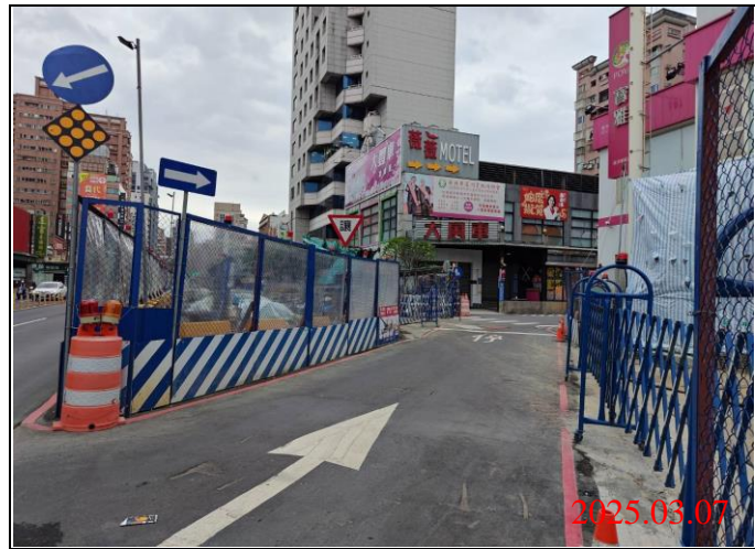
巡查日期地點：114.03.07/ Y21車站 照片說明：牌面設置狀況
