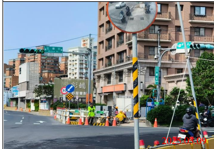
巡查日期地點：114.03.09/ Y22車站 照片說明：牌面設置狀況
