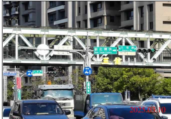
巡查日期地點：114.03.10/ Y23車站 照片說明：牌面設置狀況
