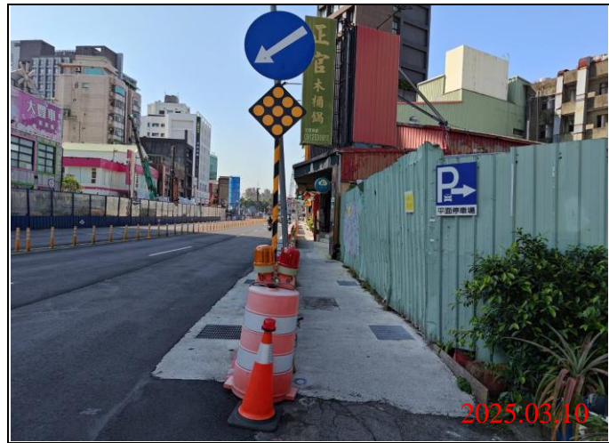
巡查日期地點：114.03.10/ Y21車站 照片說明：牌面設置狀況
