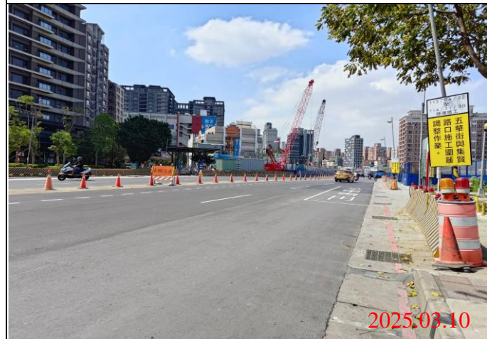
巡查日期地點：114.03.10/ Y22車站 照片說明：牌面設置狀況
