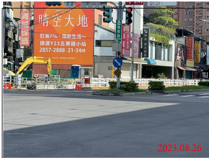
巡查日期地點：112.08.26/ Y21車站 照片說明：牌面設置狀況
