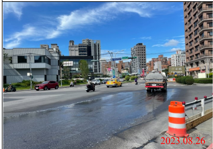
巡查日期地點：112.08.26/ Y22車站 照片說明：牌面設置狀況
