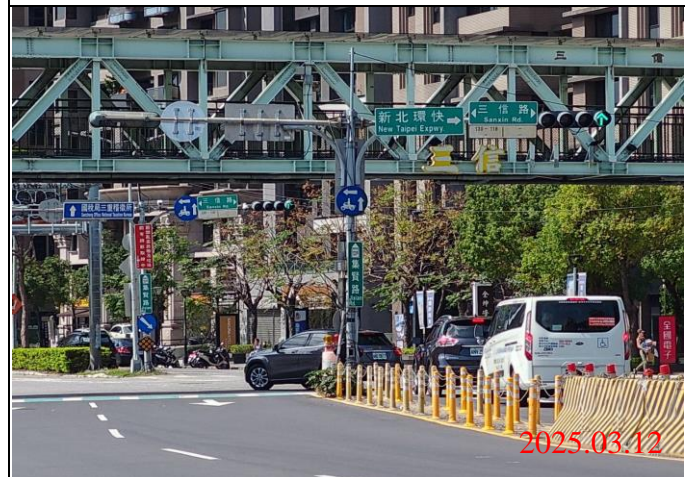
巡查日期地點：114.03.12/ Y23車站 照片說明：牌面設置狀況
