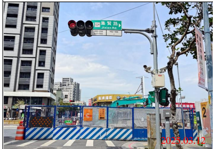
巡查日期地點：114.03.12/ Y22車站 照片說明：牌面設置狀況
