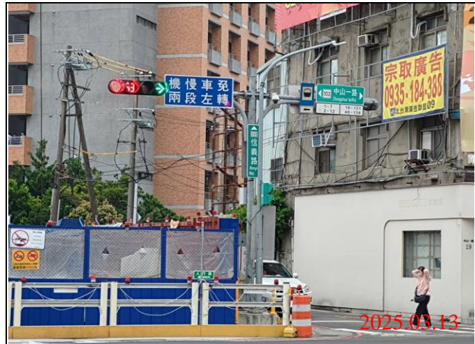
巡查日期地點：114.03.13/ Y21車站 照片說明：牌面設置狀況
