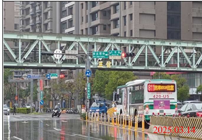
巡查日期地點：114.03.14/ Y23車站 照片說明：牌面設置狀況
