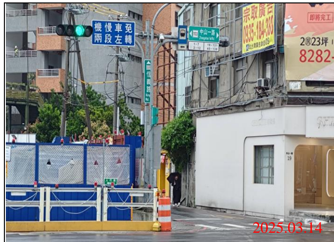
巡查日期地點：114.03.14/ Y21車站 照片說明：牌面設置狀況
