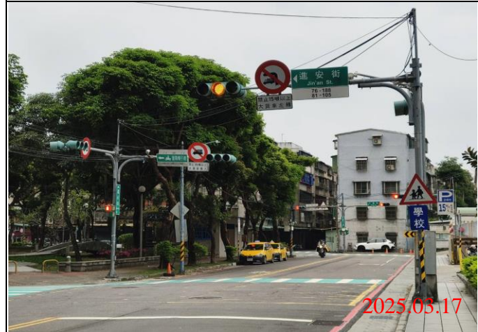
巡查日期地點：114.03.17 / Y23車站 照片說明：牌面設置狀況
