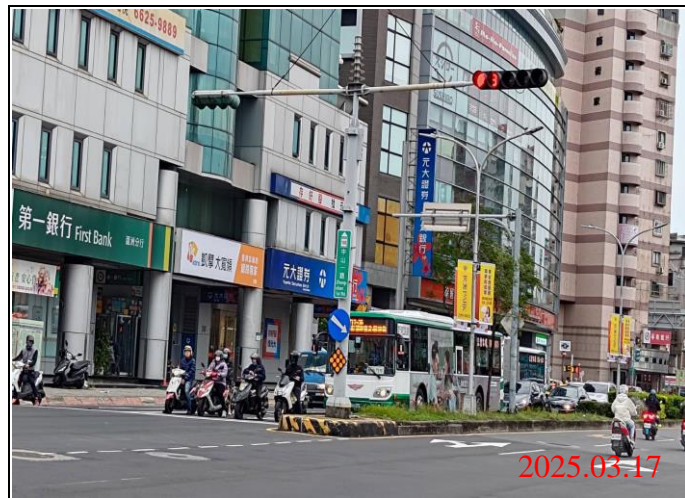
巡查日期地點：114.03.17 / Y21車站 照片說明：牌面設置狀況
