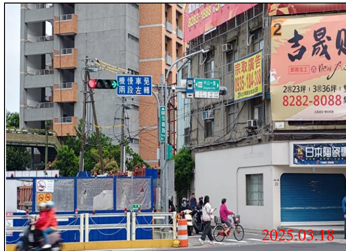
巡查日期地點：114.03.18 / Y21車站 照片說明：牌面設置狀況
