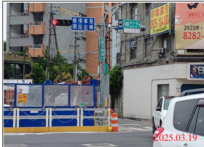
巡查日期地點：114.03.19 / Y21車站 照片說明：牌面設置狀況
