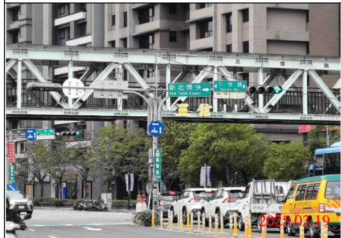
巡查日期地點：114.03.19 / Y23車站 照片說明：牌面設置狀況
