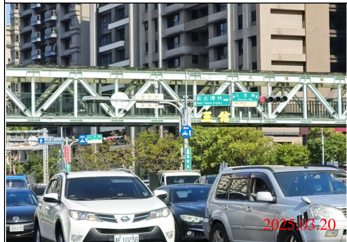
巡查日期地點：114.03.20 / Y23車站 照片說明：牌面設置狀況
