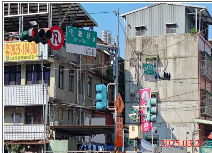
巡查日期地點：114.03.20 / Y21車站 照片說明：牌面設置狀況
