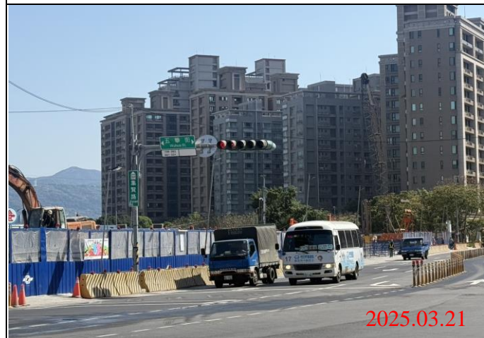
巡查日期地點：114.03.21 / Y22車站 照片說明：牌面設置狀況
