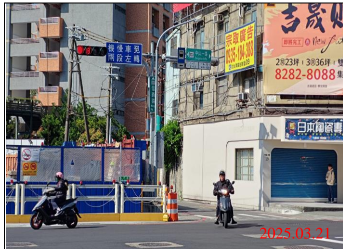
巡查日期地點：114.03.21 / Y21車站 照片說明：牌面設置狀況
