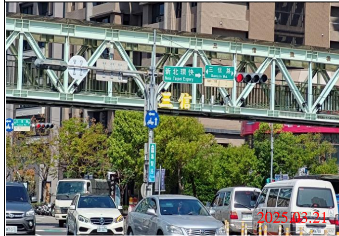
巡查日期地點：114.03.21 / Y23車站 照片說明：牌面設置狀況
