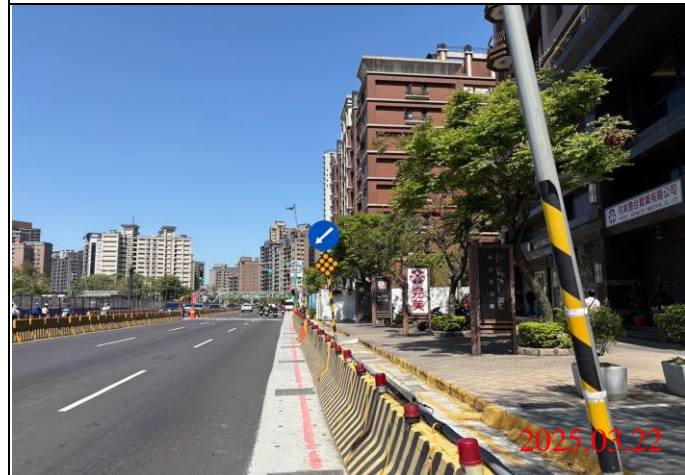
巡查日期地點：114.03.22 / Y23車站 照片說明：牌面設置狀況
