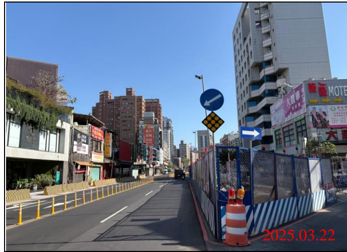
巡查日期地點：114.03.22 / Y21車站 照片說明：牌面設置狀況
