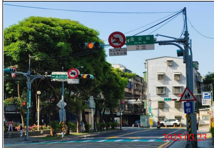
巡查日期地點：114.03.23/ Y23車站 照片說明：牌面設置狀況
