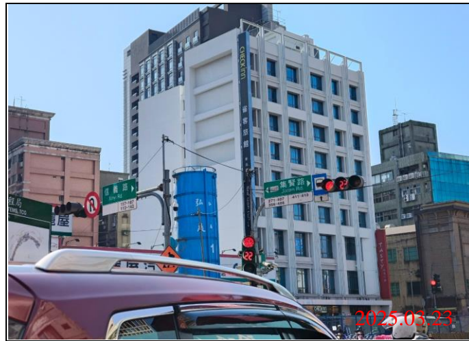
巡查日期地點：114.03.23/ Y21車站 照片說明：牌面設置狀況
