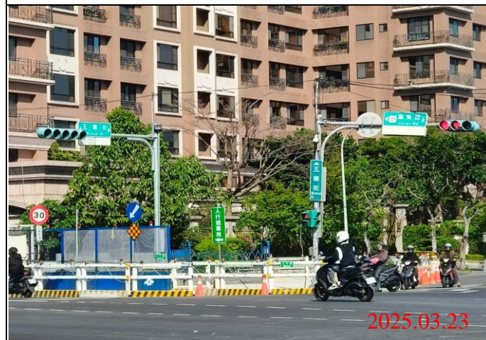
巡查日期地點：114.03.23/ Y22車站 照片說明：牌面設置狀況
