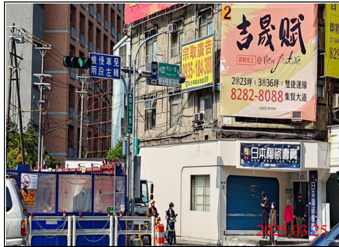
巡查日期地點：114.03.25 / Y21車站 照片說明：牌面設置狀況
