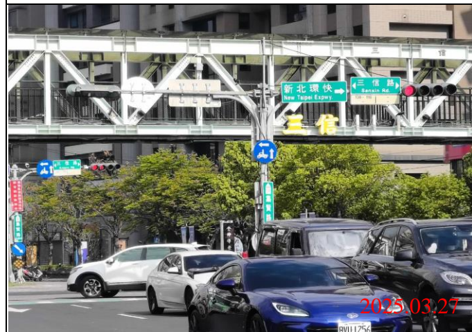
巡查日期地點：114.03.27 / Y23車站 照片說明：牌面設置狀況
