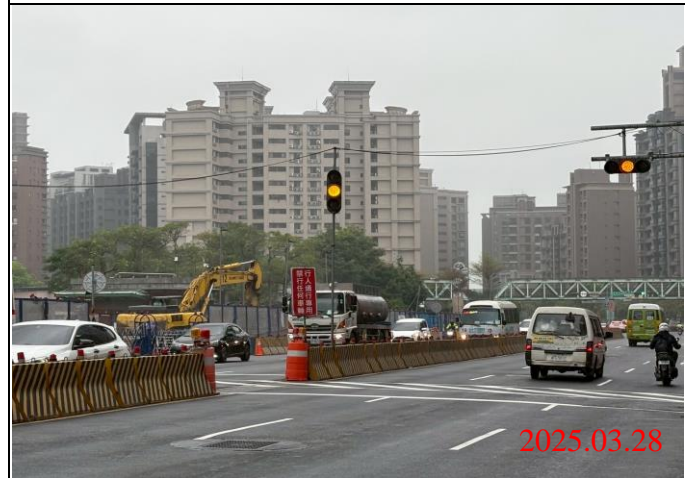
巡查日期地點：114.03.28 / Y23車站 照片說明：牌面設置狀況
