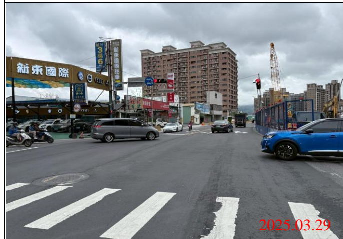
巡查日期地點：114.03.29 / Y22車站 照片說明：牌面設置狀況
