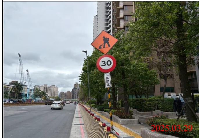
巡查日期地點：114.03.29 / Y23車站 照片說明：牌面設置狀況
