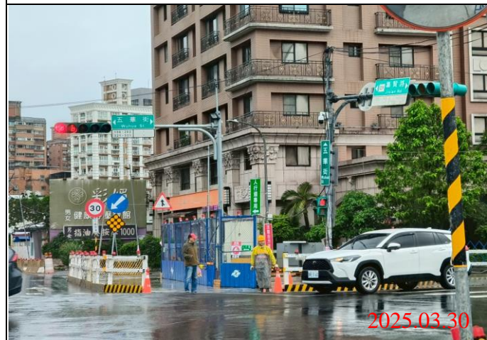
巡查日期地點：114.03.30 / Y22車站 照片說明：牌面設置狀況
