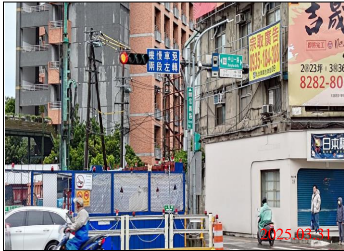
巡查日期地點：114.03.31 / Y21車站 照片說明：牌面設置狀況
