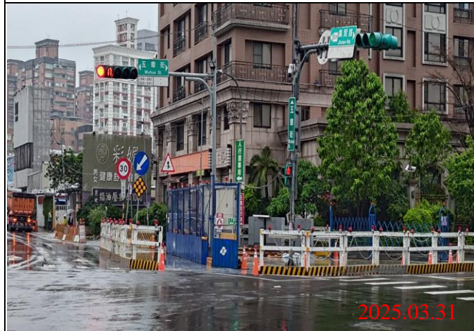
巡查日期地點：114.03.31 / Y22車站 照片說明：牌面設置狀況
