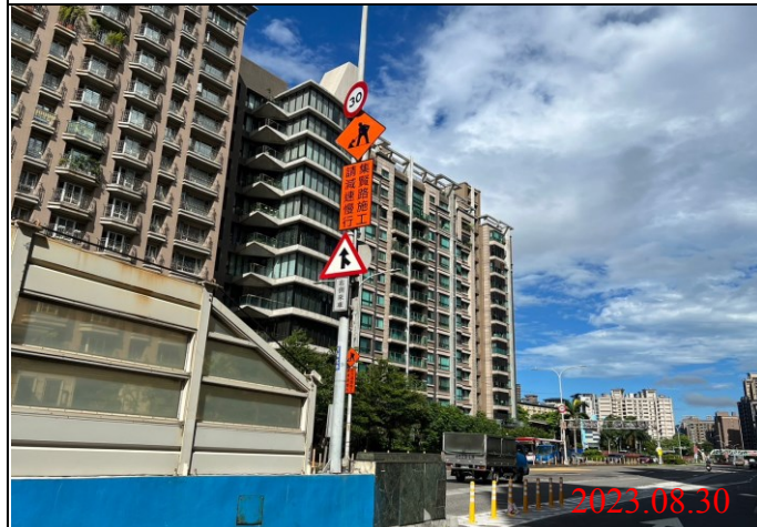
巡查日期地點：112.08.30/ Y23車站 照片說明：牌面設置狀況
