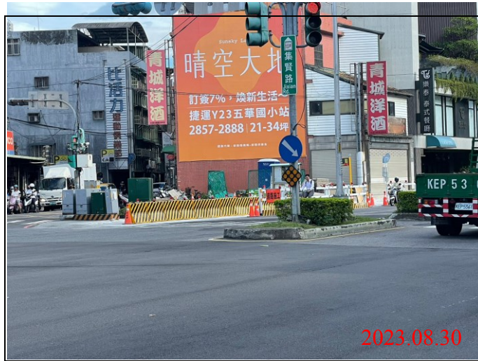
巡查日期地點：112.08.30/ Y21車站 照片說明：牌面設置狀況
