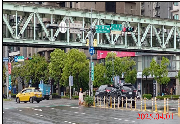
巡查日期地點：114.04.01 / Y23車站 照片說明：牌面設置狀況
