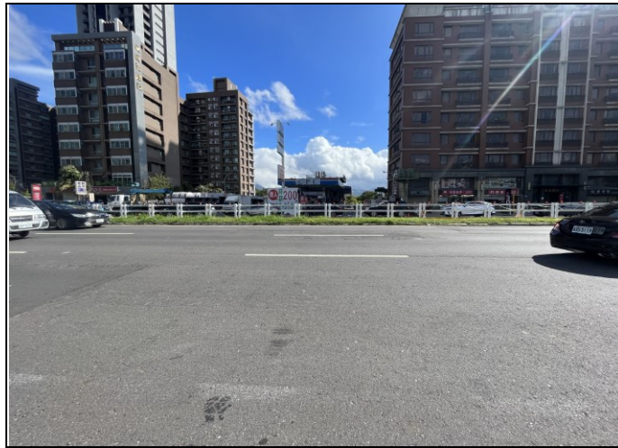
巡查日期地點：112.08.31/ Y23車站 照片說明：路面龜裂狀況
