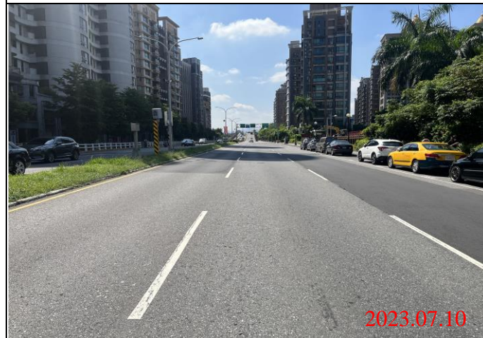
巡查日期地點：112.07.10/ Y23車站 照片說明：路面狀況
