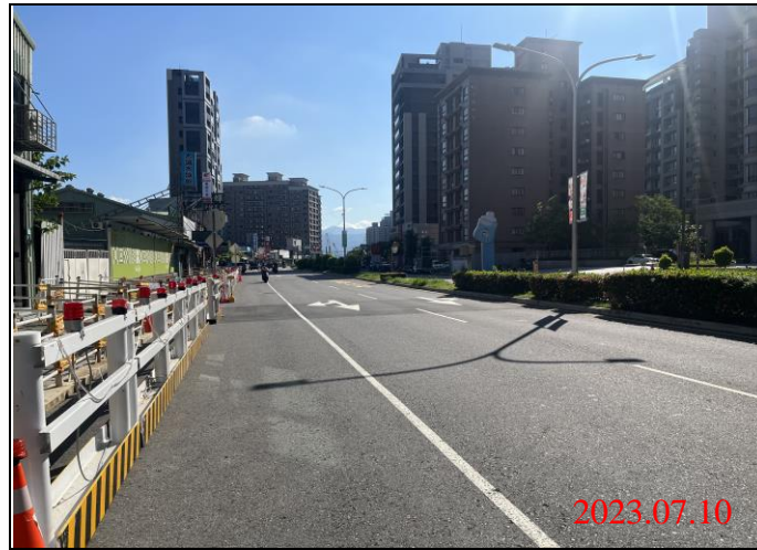
巡查日期地點：112.07.10/ Y22車站 照片說明：路面狀況
