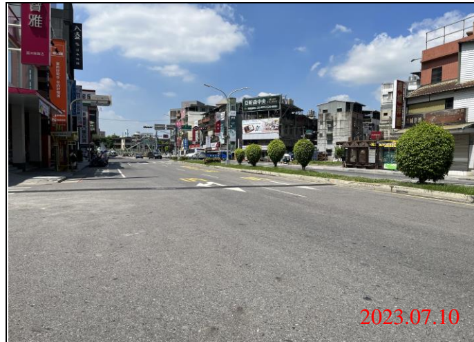
巡查日期地點：112.07.10/ Y21車站 照片說明：路面狀況
