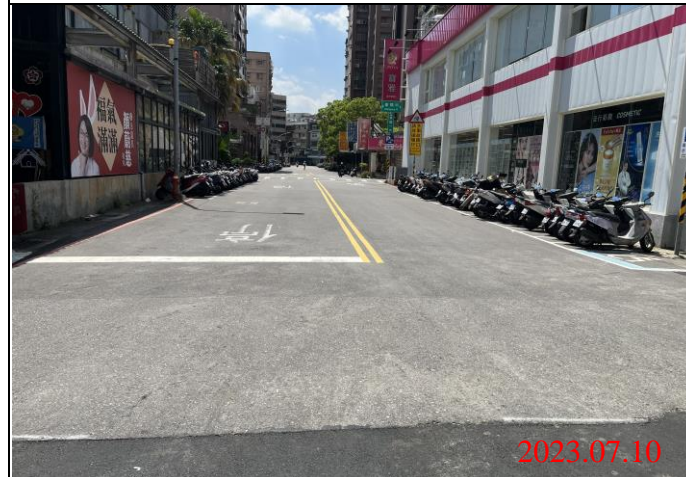
巡查日期地點：112.07.10/ Y21車站 照片說明：路面狀況
