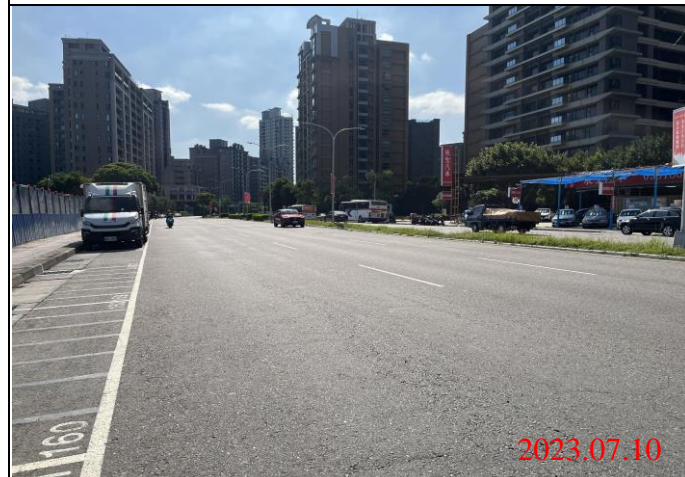
巡查日期地點：112.07.10/ Y22車站 照片說明：路面狀況
