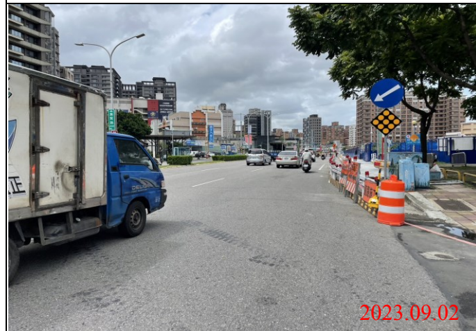
巡查日期地點：112.09.02/ Y22車站 照片說明：牌面設置狀況
