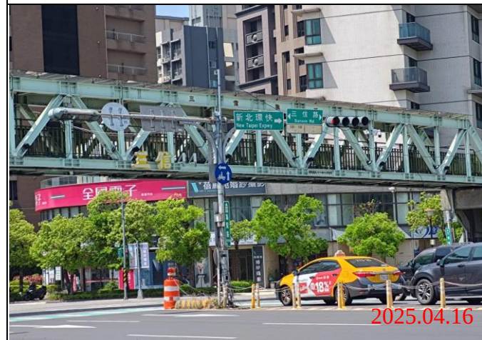
巡查日期地點：114.04.16 / Y23車站 照片說明：牌面設置狀況
