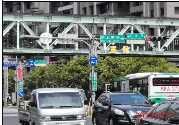
巡查日期地點：114.04.17 / Y23車站 照片說明：牌面設置狀況
