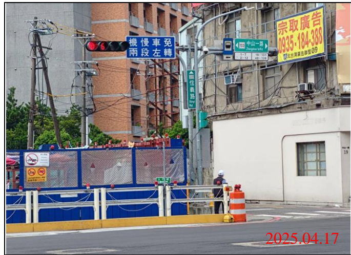
巡查日期地點：114.04.17 / Y21車站 照片說明：牌面設置狀況
