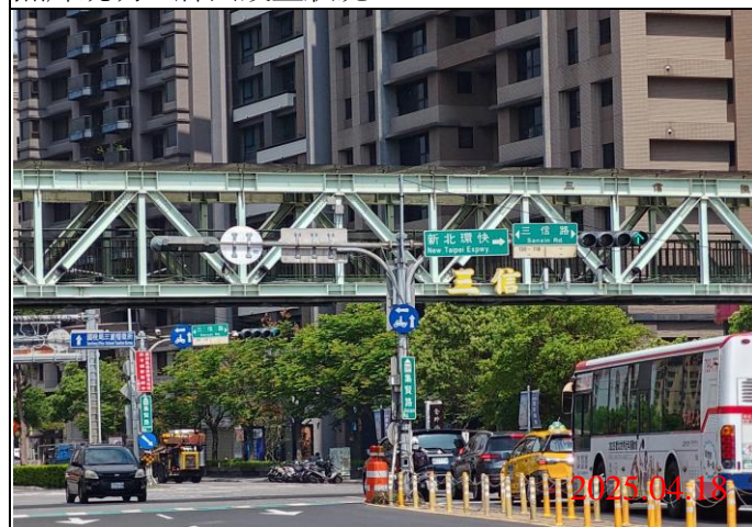
巡查日期地點：114.04.18 / Y23車站 照片說明：牌面設置狀況
