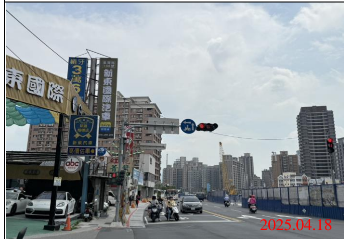
巡查日期地點：114.04.18 / Y22車站 照片說明：牌面設置狀況
