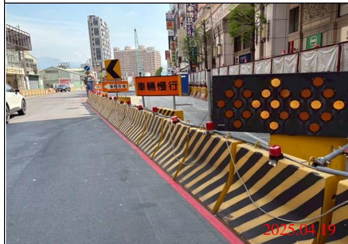
巡查日期地點：114.04.19 / Y22車站 照片說明：牌面設置狀況
