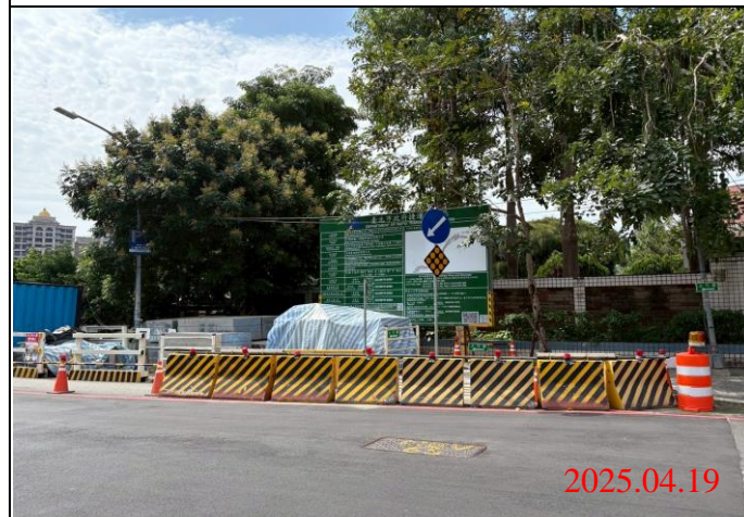
巡查日期地點：114.04.19 / Y23車站 照片說明：牌面設置狀況
