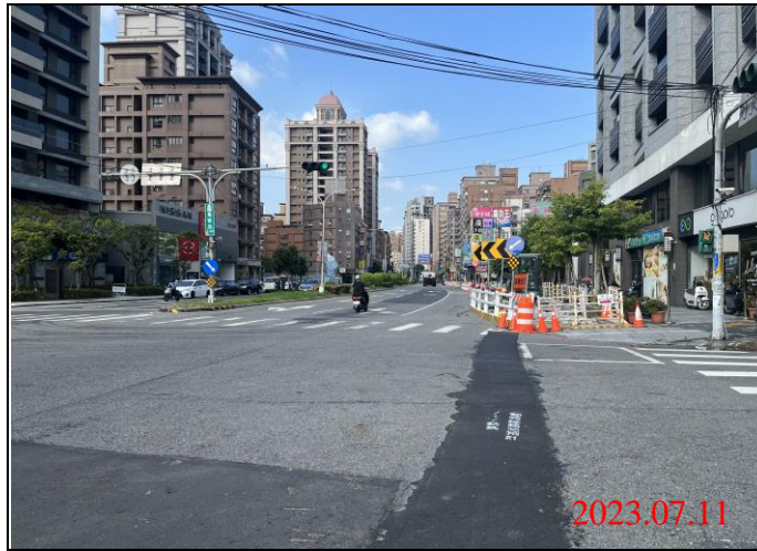
巡查日期地點：112.07.11/ Y22車站 照片說明：路面狀況
