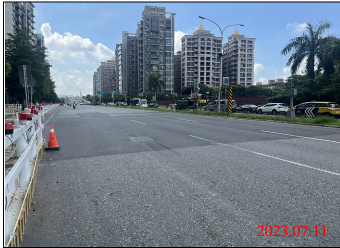
巡查日期地點：112.07.11/ Y23車站 照片說明：路面狀況
