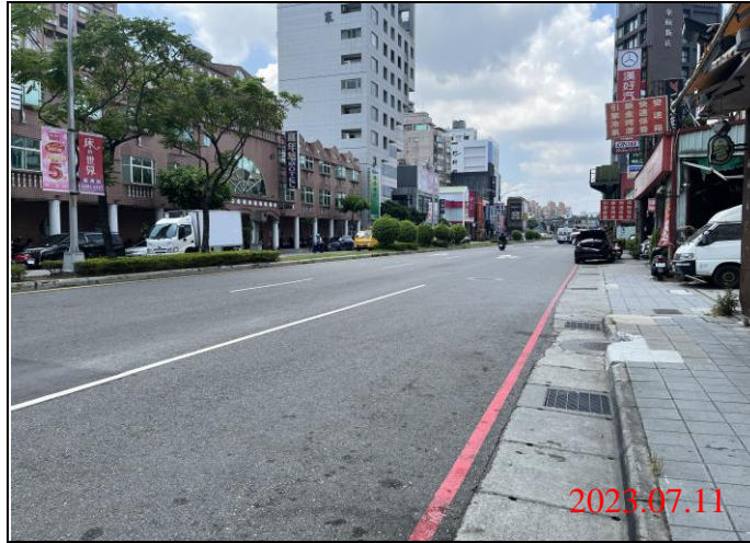
巡查日期地點：112.07.11/ Y21車站 照片說明：路面狀況
