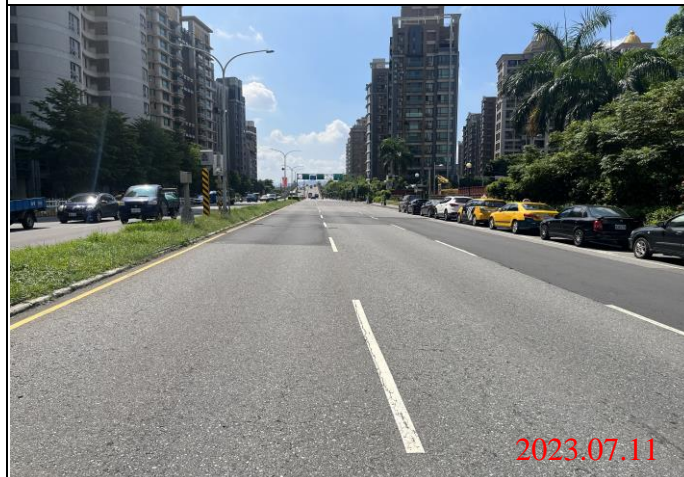
巡查日期地點：112.07.11/ Y23車站 照片說明：路面狀況
