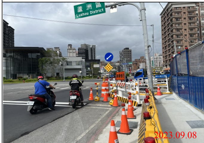
巡查日期地點：112.09.08/ Y22車站 照片說明：牌面設置狀況
