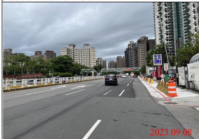
巡查日期地點：112.09.08/ Y23車站 照片說明：牌面設置狀況
