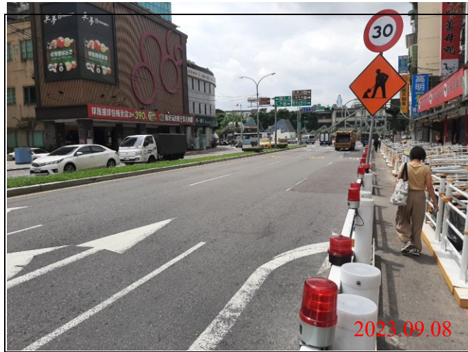
巡查日期地點：112.09.08/ Y21車站 照片說明：牌面設置狀況
